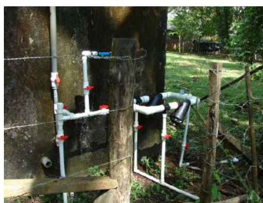
Instalación de sistema de riego por goteo
