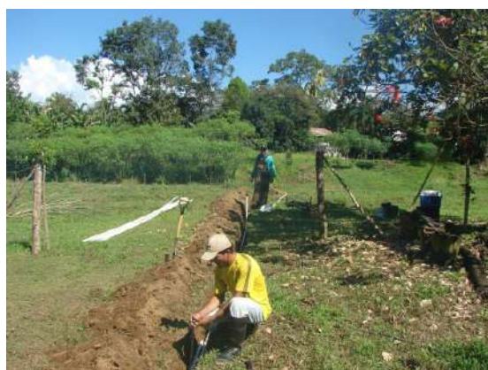
Instalación de sistema de riego por goteo
