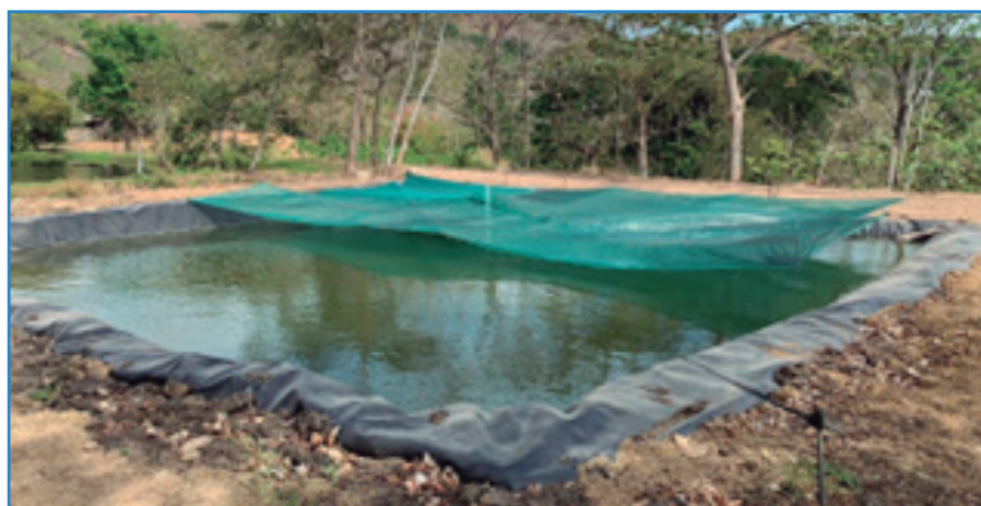
Figura 68. Reservorio de agua. Atenas. 2021
