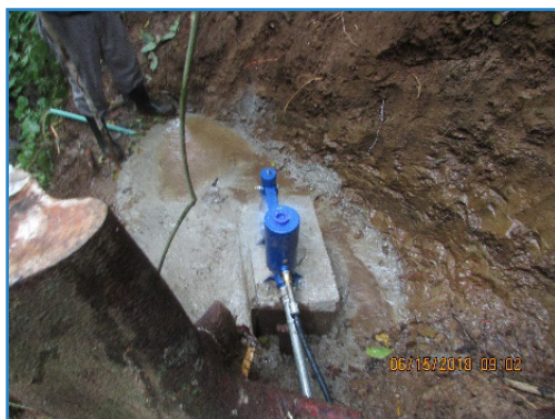
Figura 61. Instalación de ariete y manejo de pasturas en Turrubares. 2018.
