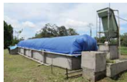
Figura 94. Biodigestor manejo remanentes de la granja porcina. EELD 2013.
