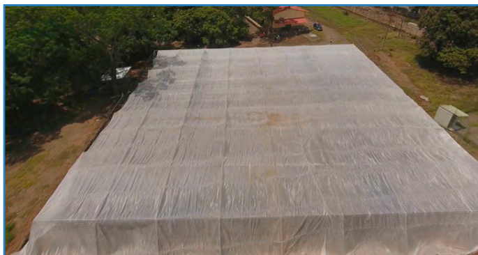
Figura 83. Módulo productivo de casa de malla de 2500 m 2 ubicado en Barranca de Puntarenas. 2020.
