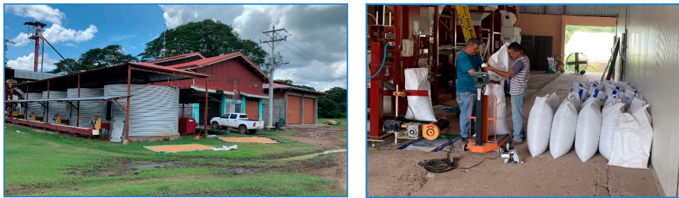
Figura 105. Planta de procesamiento y acondicionamiento de semilla. EEEJN.
