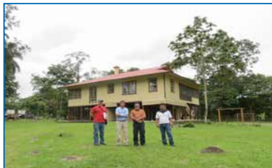
Figura 108. Casa de huéspedes después de la restauración.
